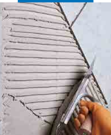
Montering af enkeltbrændte fliser på betonvægge med ekspanderet skum
