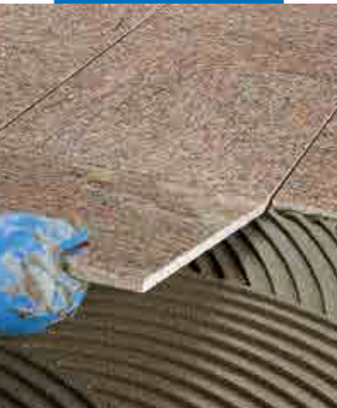
Montering af poleret marmor på gulve
