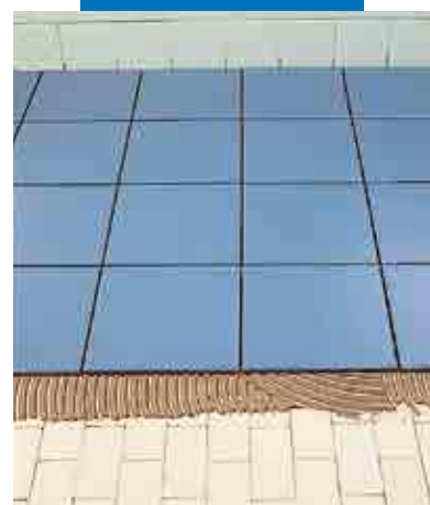
Flise på flise med grå Keraflex
