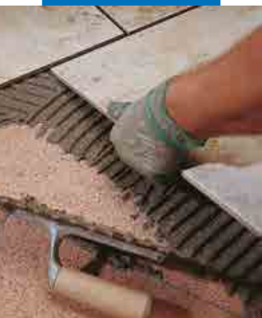
Enkeltbrændt flise på terrazzo flise på ydermur
